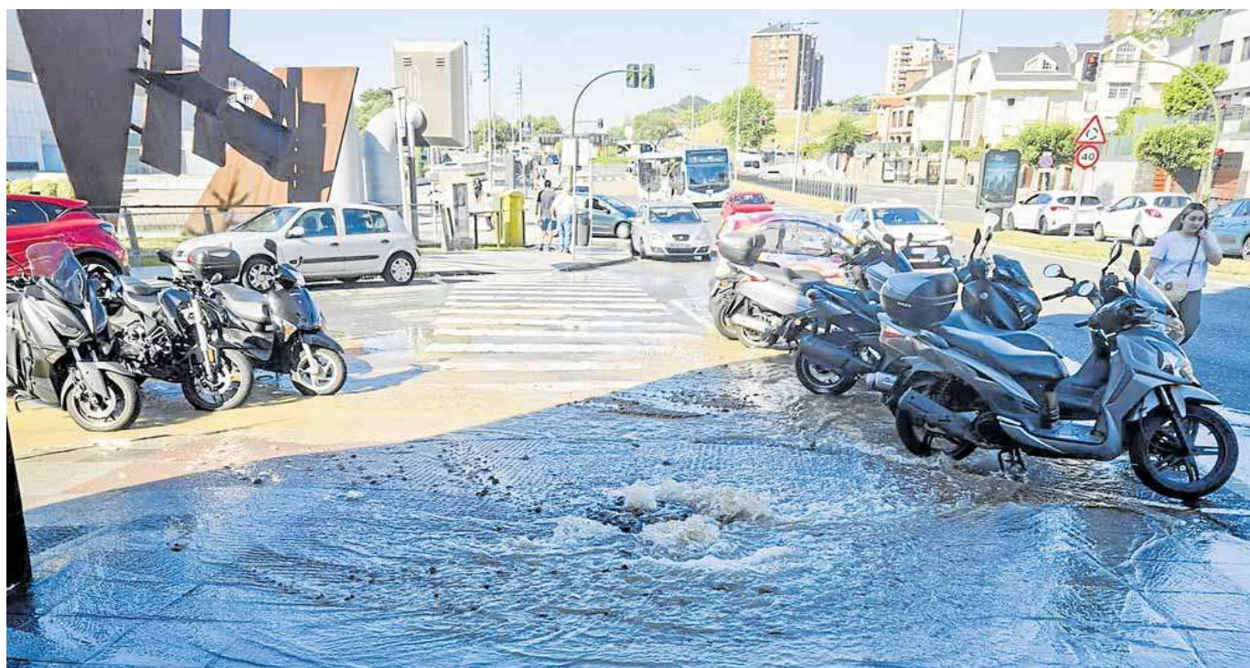
Alcantarilla en la intersección entre la Avenida Valdecilla y la calle Padre Rábago donde se produjo un reventón que dejó la zona sin abastecimiento de agua. JUANJO SANTAMARÍA
