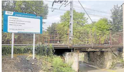
Obras de ampliación de un saneamiento en Pola de Siero, junto al cauce del río Nora y las vías de Feve. A. F. G.
