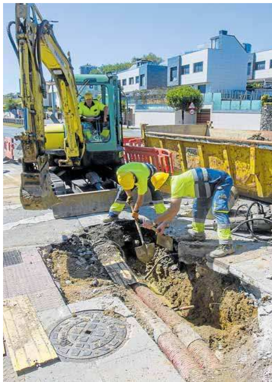
Operarios del servicio de agua durante la reparación. JAVIER COTERA
